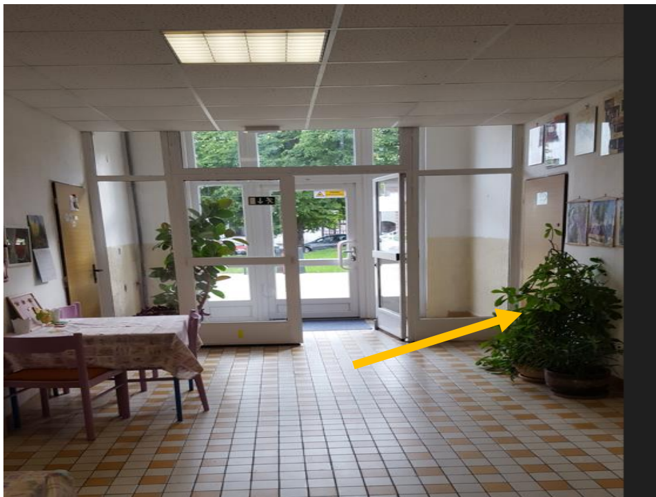
Vyústění CHÚC (pravá) – požární dveře vpravo ústí ze schodiště (CHÚC) do nechráněné únikové cesty – chodby v 1. NP a teprve potom přes dvoje plastové dveře na volné prostranství. Žlutá šipka směřuje na požární uzávěr oddělující chodbu od CHÚC
