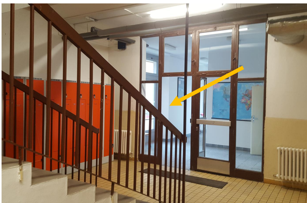
Vyústění CHÚC (levá) do chodby zástavby pod spojovacím krčkem a potom výstup na volné prostranství
